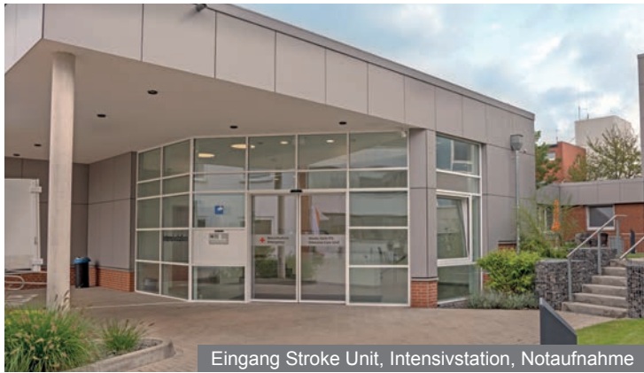
Eingang Stroke Unit, Intensivstation, Notaufnahme
